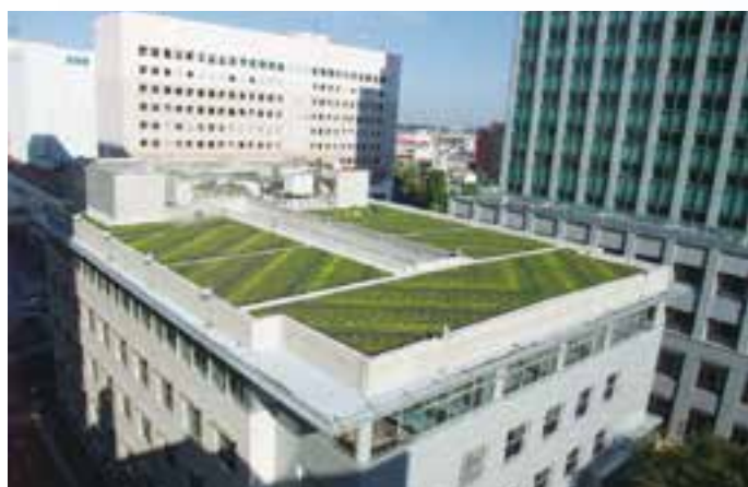
津田沼6号館の屋上緑化
