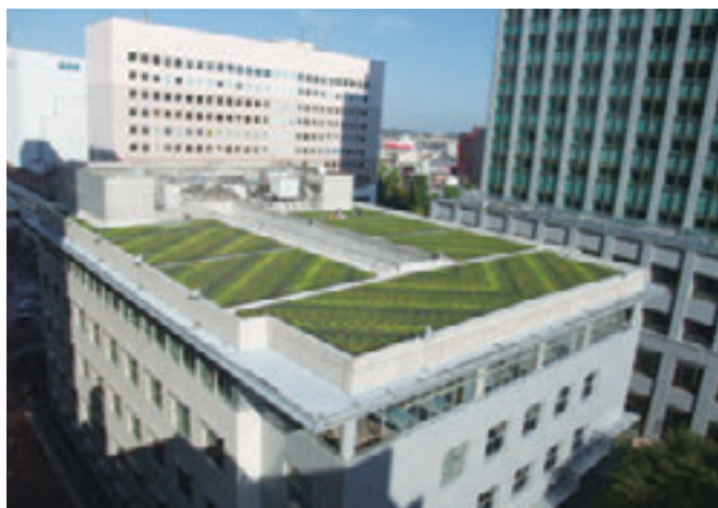
津田沼6号館の屋上緑化
