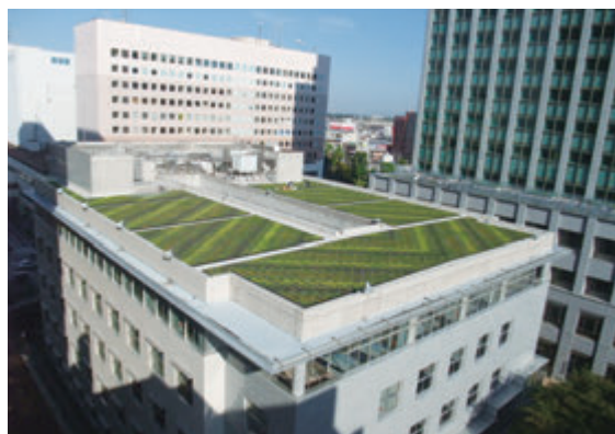
津田沼6号館の屋上緑化
