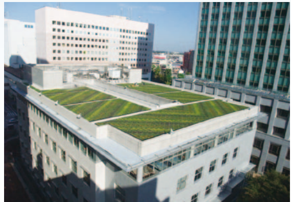
津田沼6号館の屋上緑化
