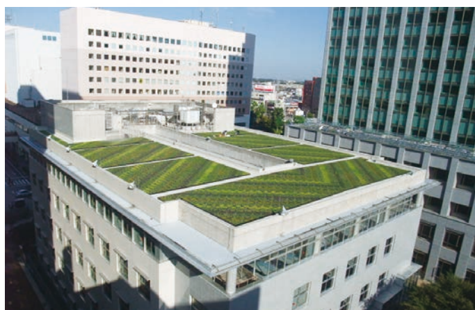
津田沼6号館の屋上緑化
