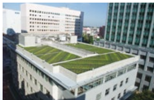
津田沼6号館の屋上緑化
