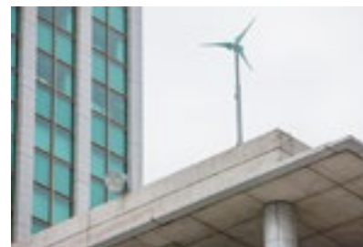
6号館屋上の風力発電設備
