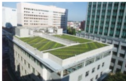
津田沼6号館の屋上緑化
