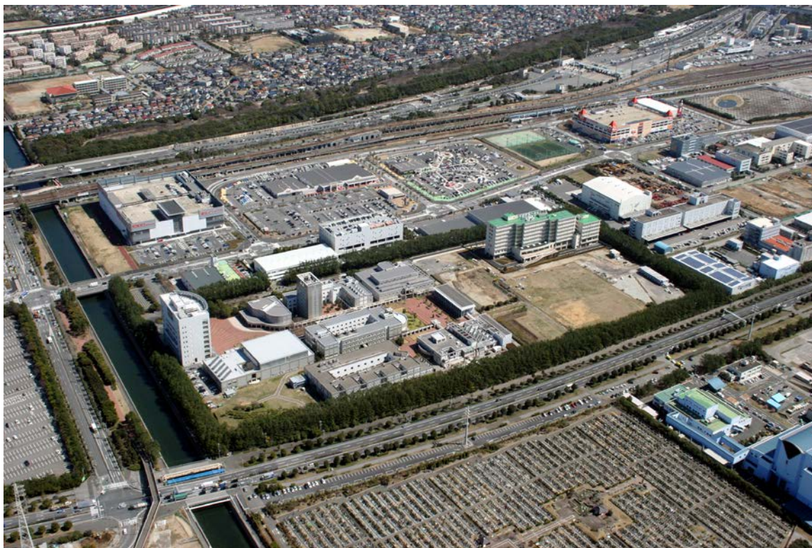
写真 A-2-1 キャンパス整備により建設した施設(2014 年 3 月撮影)
