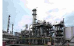
ポリマー製造プラント
