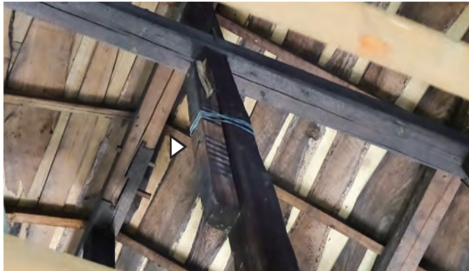
2022年、中央柱の上部で発見された幣串(▷印=建物解体時)
