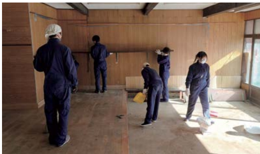
空き家の状況を調査
